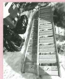
小型除雪機を運搬するためのスロープを整備
